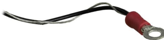
图 4-68: 黑线和引流线已压接到环形端子上
